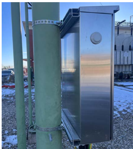
Slika 4: Primer izvedbe montaže el. omarice na podstavek VN aparata v objemni izvedbi.
